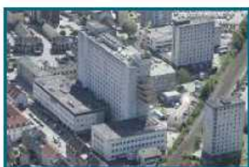
Aalborg Sygehus Afsnit Nord
